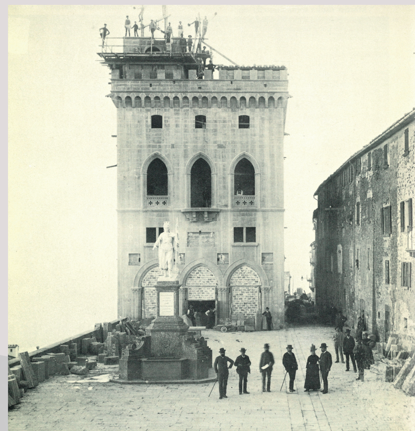
Il cantiere del nuovo Palazzo. La torre è già stata realizzata e gli operai si fanno ritrarre sulla sua sommità; sul Pianello restano accatastati i materiali da costruzione. Da G. Rossi, San Marino nelle vecchie fotografie , 1982
