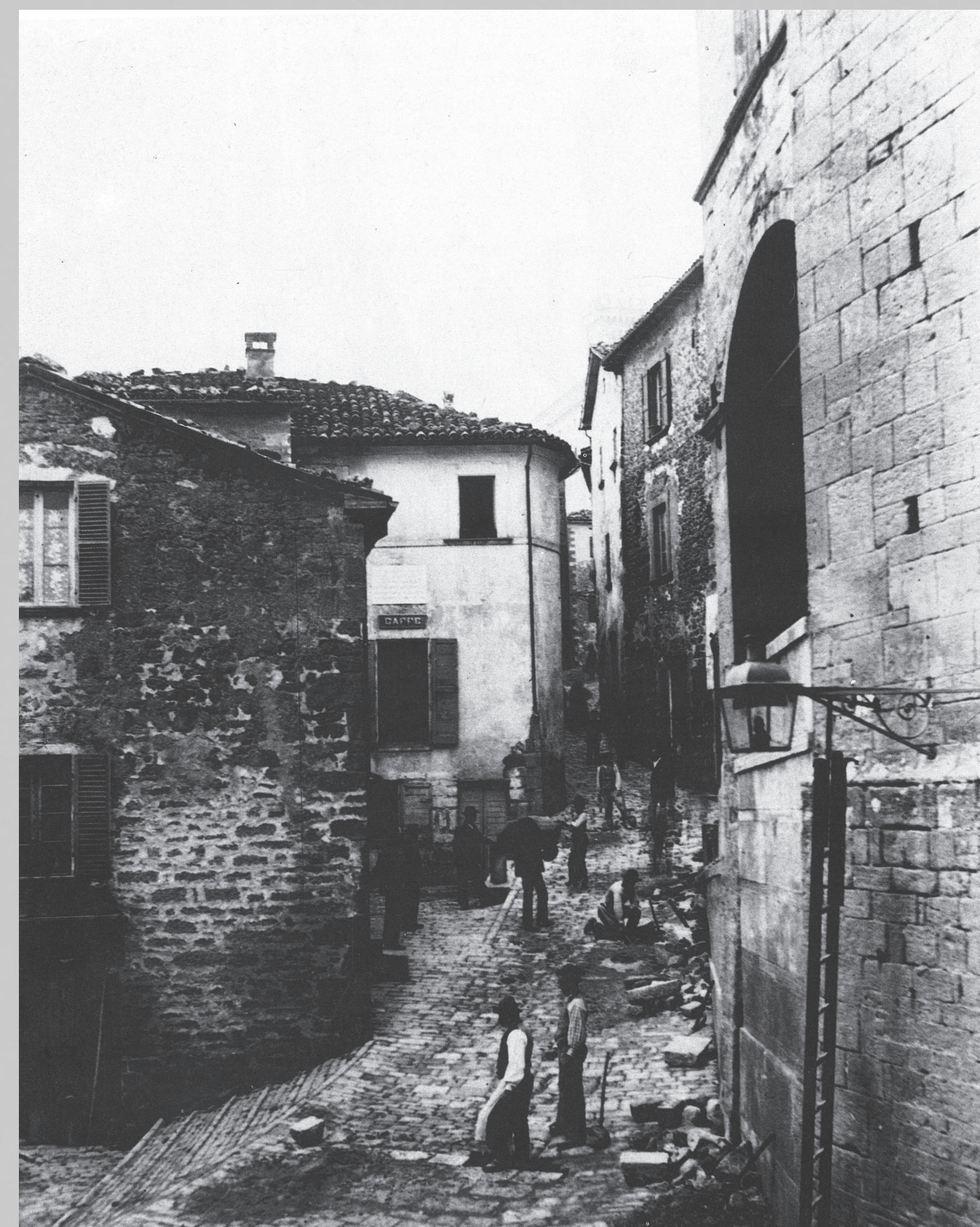
Via Basilicium durante i lavori per il restauro del selciato. Da G. Rossi, San Marino nelle vecchie fotografie , 1982
